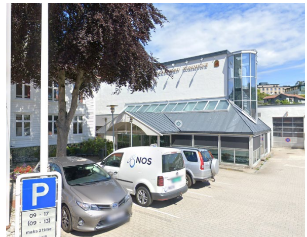
Figur 10 - Kirkegaten 50, eksisterende rådhus. Den gamle brannstasjonen anes til høyre (kilde: googlemaps)
